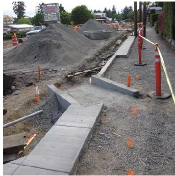
MOD. GRAVEL LAYER
